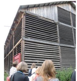
Sarvien kuivaustalo Kuva: Sanna Kauppinen
